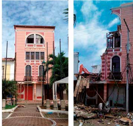
Figura 14. La casa Nevárez Páez, después del terremoto de 2016. Antes de ser demolida (i), y después de dicha tarea (d). Fuente: Graciela Moreno.
